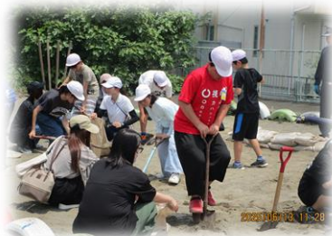
6年生：土嚢・杭打ち
